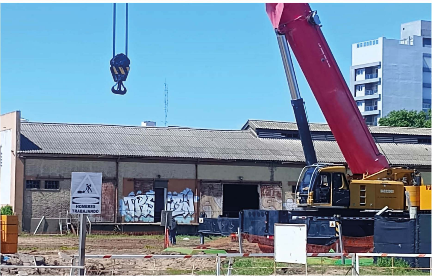
Rivadavia y las vías, martes 20 de octubre, 11 horas. Las grúas no se movieron luego del cambio de lugar de una viga que permitió a Petrecca hacer un acto y disparar cotillón.
