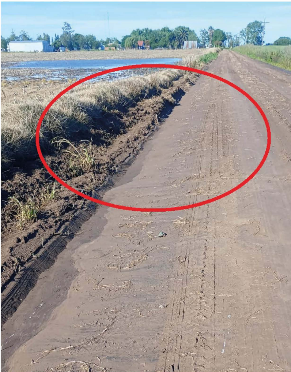
Sin zanja fue dejado el cordón en el camino.
