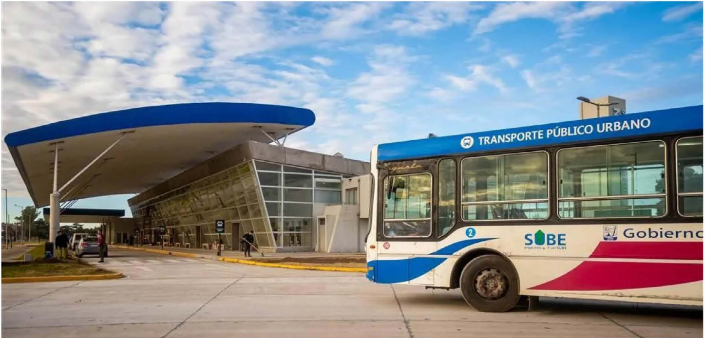
Junín tiene nueva terminal de ómnibus que aún continúa en obra después de quince años.
